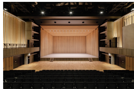
音響反射板を設置した舞台
