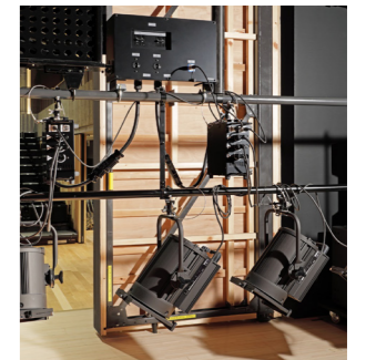
サスペンションライト コンセントボックスと移動型調光器
