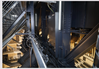
シーリングライト電源盤 1φ3W 30kVA×2
