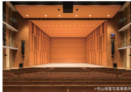
大ホール 音響反射板を設置した舞台
